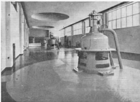
Kuva 11. Sisäkuva Keltin voimalaitoksesta. Päägeneraattorit lattian alla.
