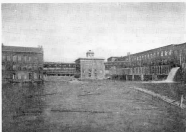
Kuva 8. Kymintehtaan sähkökeskus ulkoa. Oikealla hiomon ränni. Vasemmalla olevan rakennuksen alim- massa kerroksessa on Kuusankosken sähkökeskus.
