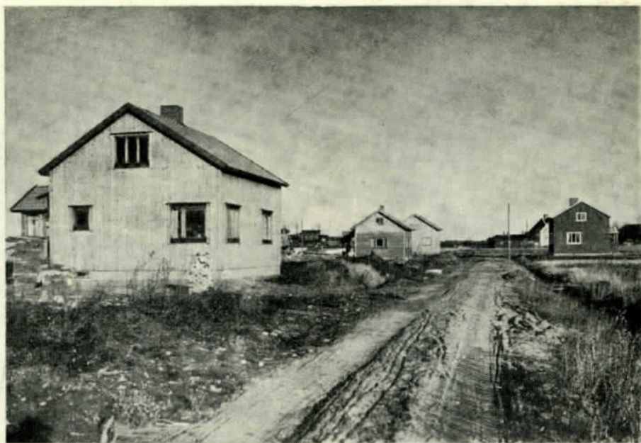
Itäisen pään valmiita taloja, joista oikealla sijaitseva Huumosen talo oli ensimmäisenä asuttavassa kunnossa. Vasemmalla Huuskosen, Korpelaisen ja Utin talot.
