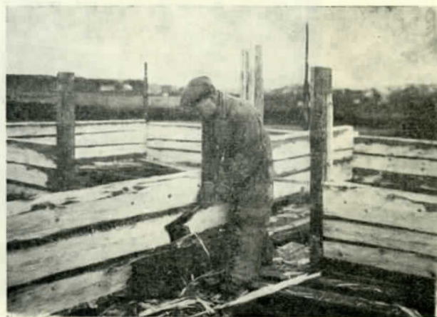
Lauri Syväjärvi talonsa rakennuspuuhissa.
