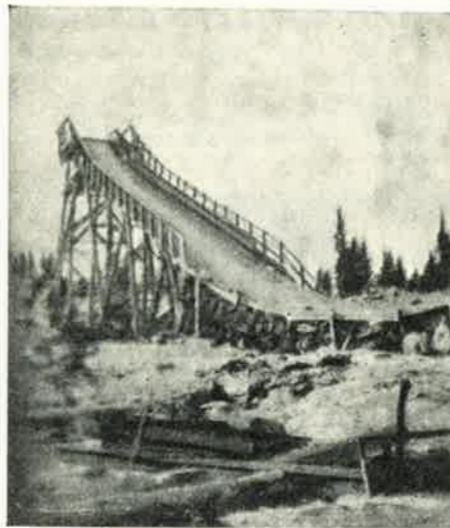
Hyppyrimäki rakennusvaiheen aikana.
