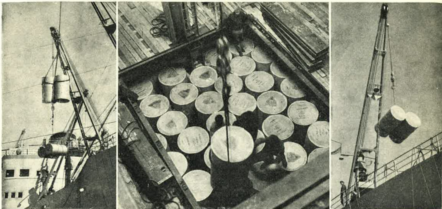
Vasemmanpuoleisessa kuvassa ovat rullat nousseet "huippukorkeuteen", oikealla hellauttaa nostorana ne laivan kaiteen yli ja keskimmaisessä kuvassa nähdään niiden laskentuvan laivan syvyyksiin. Lastiruumat ovat useampikerroksisia ja niitä on laivassa monta.
