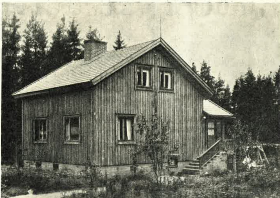
Lauri Hämäläisen rakentama talo Takaharjussa.
