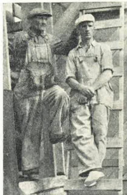
Levyseppä Toivo Kojärvi vanhempi veli apunaan on myös rakentanut oman talon, johon pääsee piakkoin muuttamaan.
