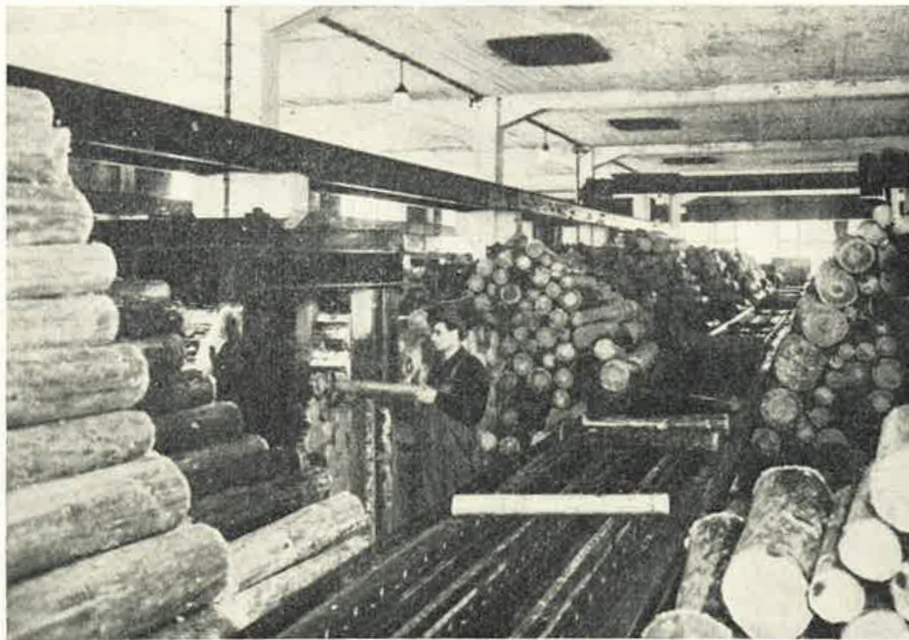
Kuva 7. Puuhiomon toinen kerros kuljetuslaitteineen ja pöllivarastoineen. Etualalla ladotaan pöllejä hiomakoneeseen.
