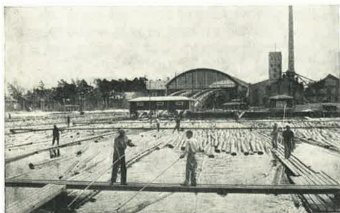
Tukit erotellaan ja "suomustetaan" kukin paksuus omaan luokkuunsa. Taustalla näkyvät kuljettimet vievät tukit sahaan, —
