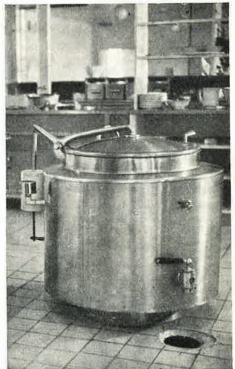
Höyrylämmityksellä toimiva 100 litran vetoinen keittopata.
