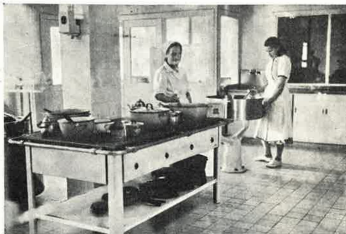
Sähköliesi, taaempänä sähkökäyttöinen paistinpannu.
