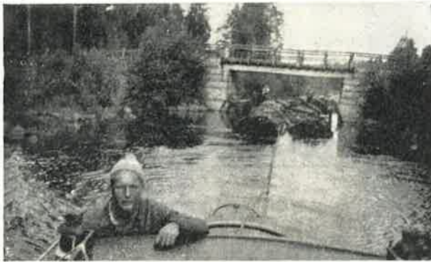
Nippujono alittaa 4 m. levyisen sillan.
