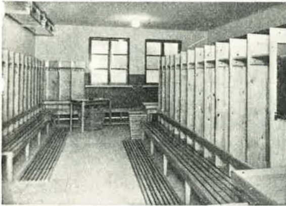
Pukuhuoneen toinen puoli.
