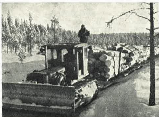
Telaketjutraktori talvityössä Kajaani Oy:n työmaalla. — Valok. Metsäteho.
