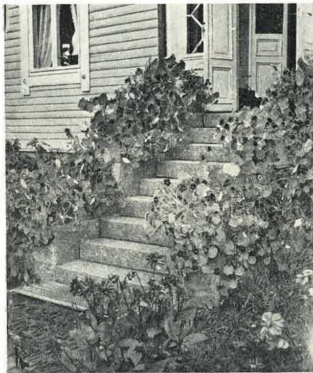
Köynnöskasvit ovat kiitollisia apuvälineitä pihamaan kaunistajalle. Niillä voi peittää rumia kiviä jalkoja, seinäpintoja ja kuisteja. Tässä köynnöskrassi ( Tropaeolum ) verhoaa hauskaasti korkeiden rappujen sivuja.
