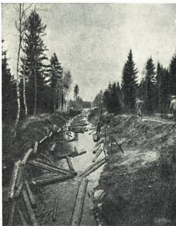
Kaivetussa kanavassa kulkevat puut vaivattomasti.
