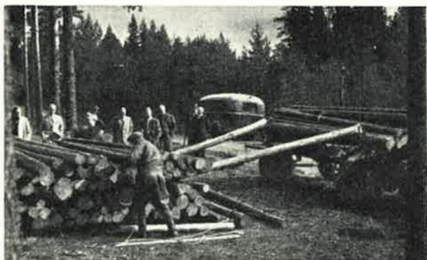
Kuormaus Isachsenin kuormauslaitteella.
