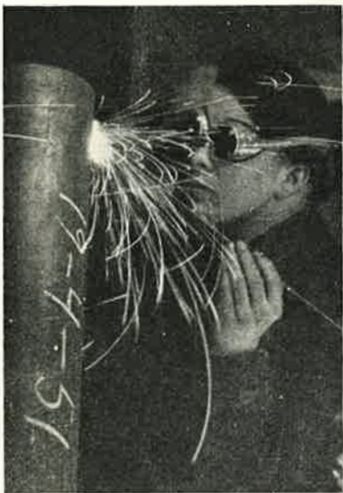
Kipinöiden viuhkana sinkoillen suorittaa jatkokurssilainen Väinö Toivonen näytettyä pystysaumahitsauksessa.
