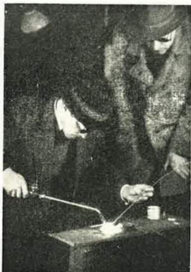
Ins. Öster suorittamassa kaasuhitsauksen taitavuuskoetta ins. Martelinin valvoessa toimitusta.
