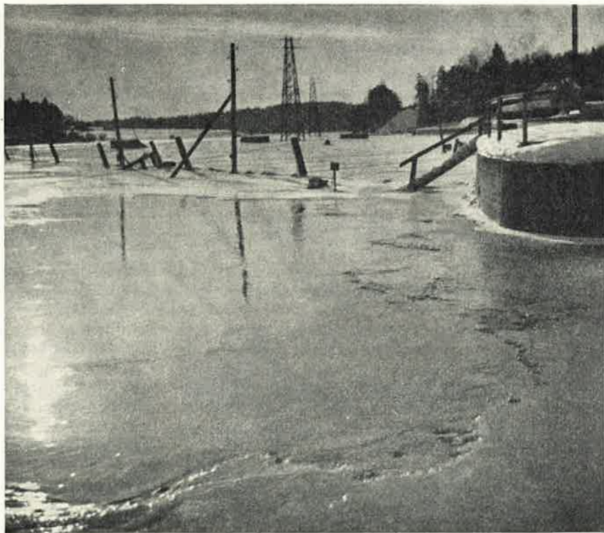
Kymijoen talvista tunnelmaa voimalaitoksen yläpuolella.
