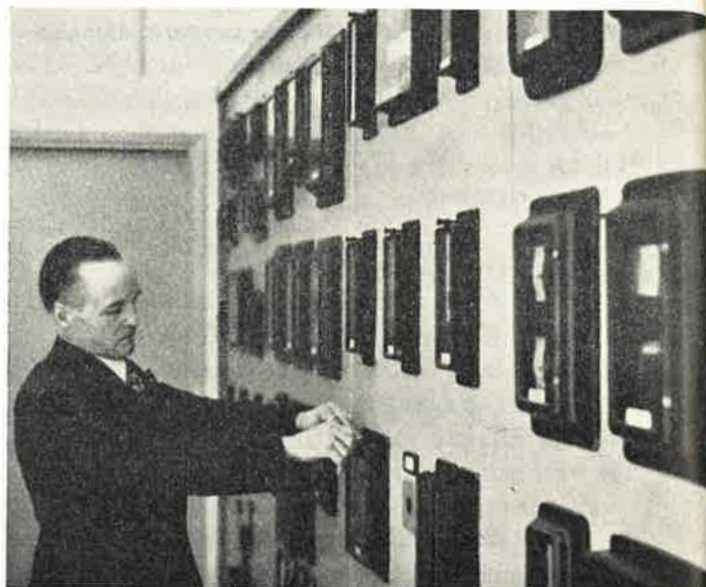
Voimalaitosmestari Valto Lahtinen tutkimassa generaattorien suojareleitä.
