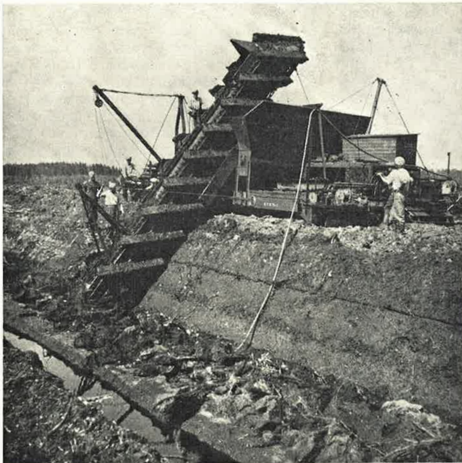
Haukkasuon uusiin Hesper-kone etenemässä pitkän montun laitaa.
