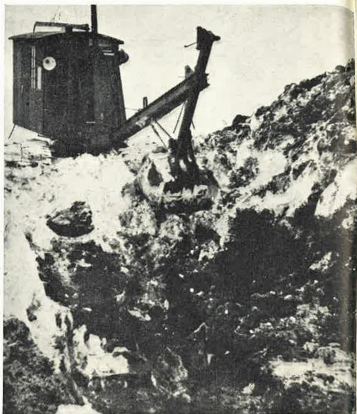
Turve-Jussi talvisaikaan suurta viemäriä kaivamassa. Viereisellä sivulla: Kätevä siirtolaite nostaa Utin aseman lastauspaikalla turpeen pikkuvaunuista rautatievaunuihin.
