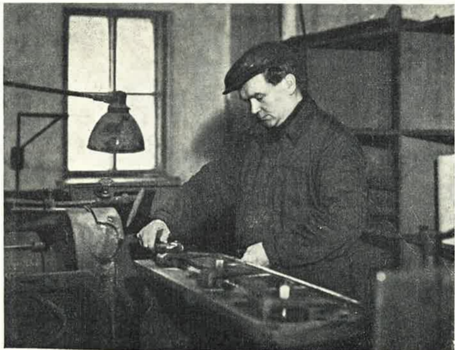
Onni Utti kiinnittämässä hakkuuterää hiomakoneeseen.
