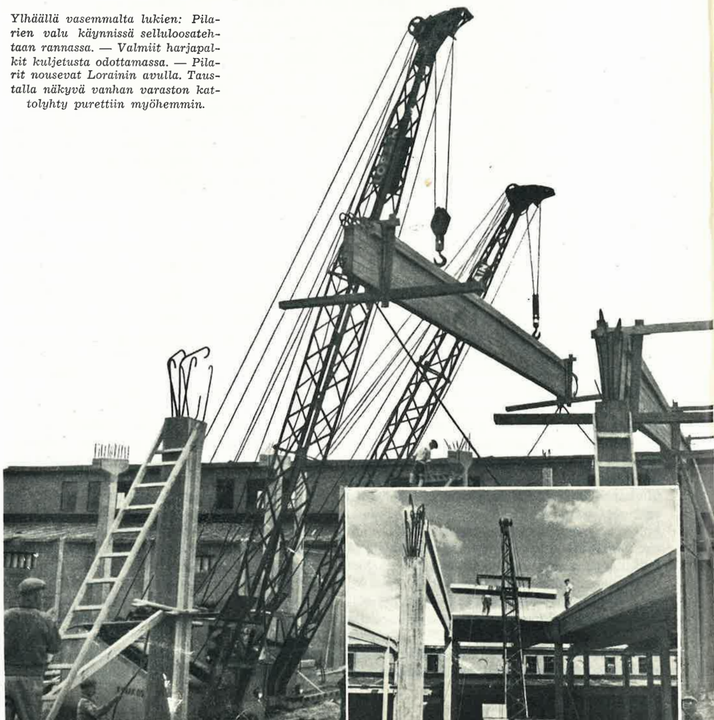
6.5 tonnin painoisten kattopalkkien asennus käyn- nissä kahden Lorainin avulla. Nämä palkit valettiin rakennusalueella. — Vieressä: Ripalevyjen nosto menossa.
