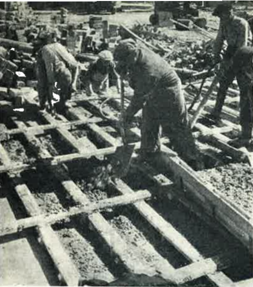
Ylhäällä vasemmalta lukien: Pila- rien valu käynnissä selluloosateh- taan rannassa. — Valmiit harjapal- kit kuljetusta odottamassa. — Pila- rit nousevat Lorainin avulla. Taus- talla näkyvä vanhan varaston kat- tolyhty purettiin myöhemmin.
