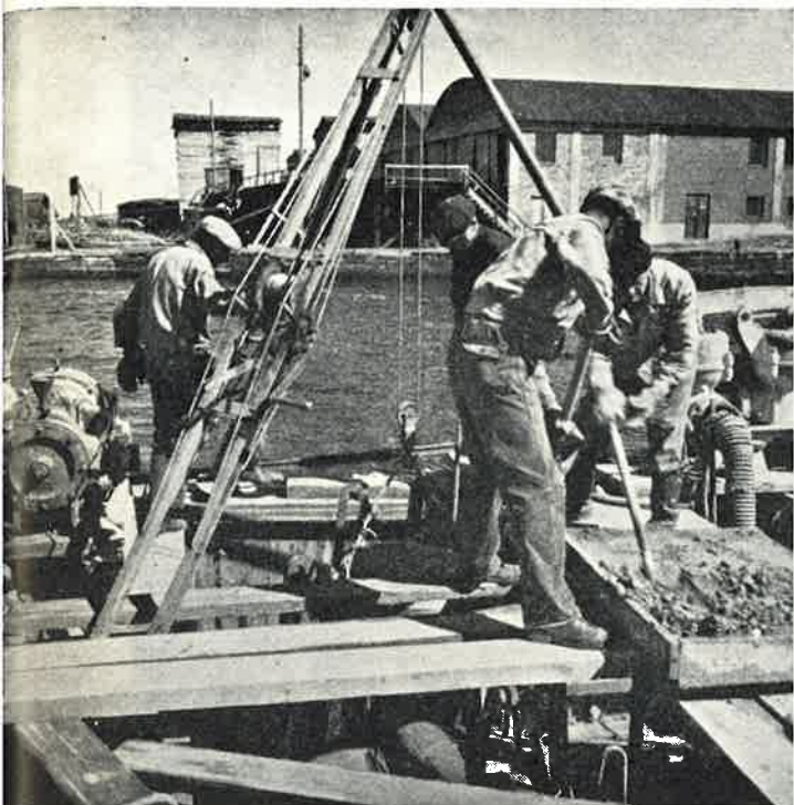
Puujalansalmessa ovat koko kesän olleet uuden siltanosturin perustustyöt käynnissä. Yläkuvassa erään pilarin vedenalaisten osien betoninvalu käynnissä.
