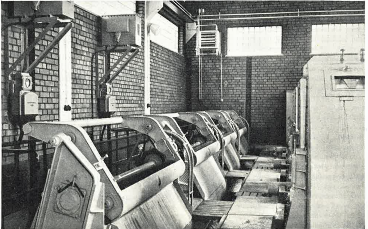
Vedenpuhdistuslaitoksen koneistoa. Vasemmalla karkeapuhdistajat eli vältit ja oikealla pyörivät eli hienopuhdistajat. Seinillä sulatusmuuntajat. Alakuvassa yksi pumppuaseman komeista pumpuista.
