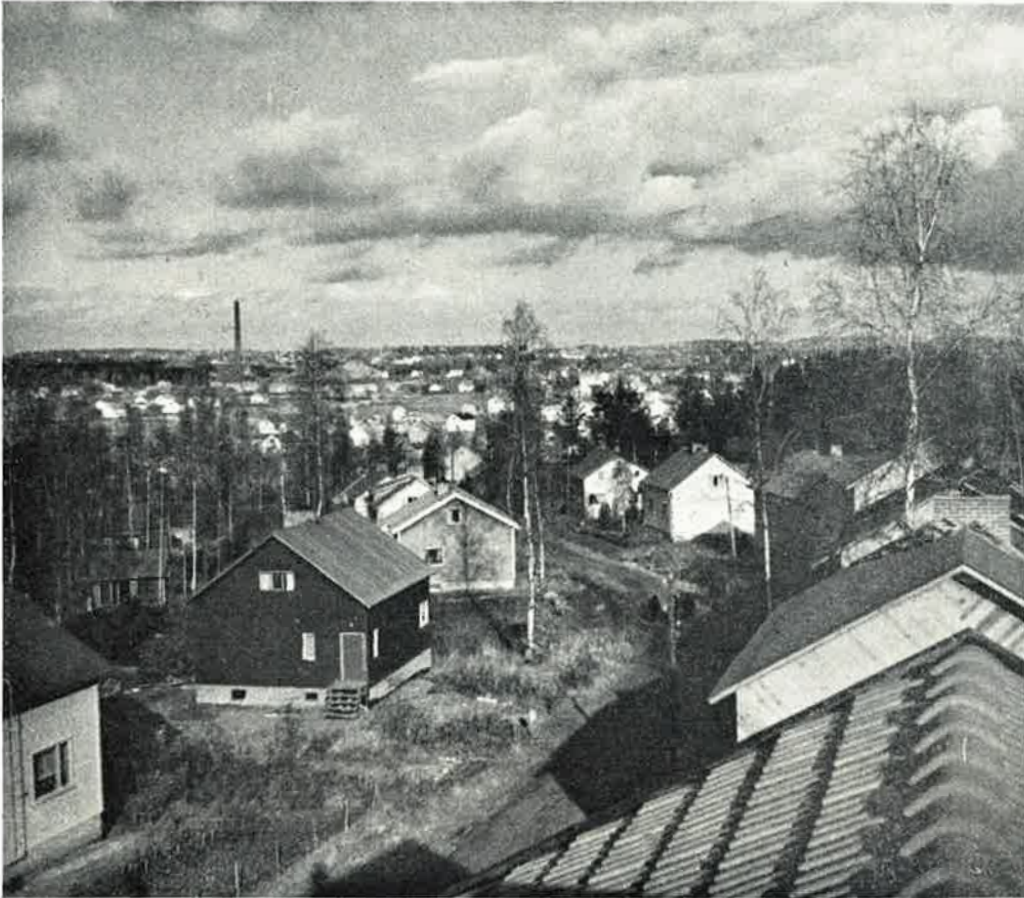
Yleiskuva markantonttialueelta Kymenrannassa. Osa taloista on rakennettu tasiselle pellolle, osa taasen met-sän suojaan. Kaartava tie antaa asemakaa-valle vaihtelua.
