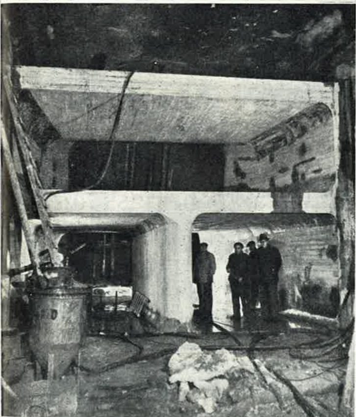
Ylinnä: Osina tuotu imutorvi on hitsattu kokoon ja sitä ollaan parhaillaan laskemassa turpiinikammioon.
