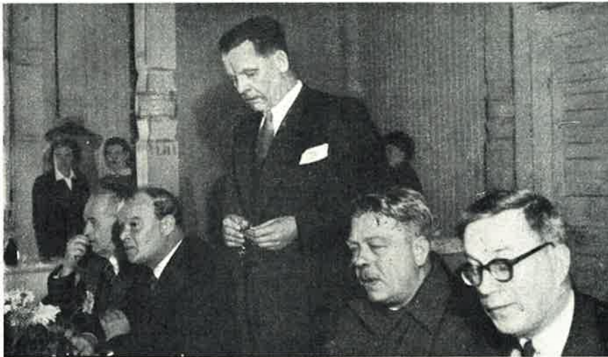
Teknillisen osaston päällikkö Björn Sucksdorff puhumassa harjannostajaistilaisuudessa. Hänestä vasemmalle Oy. Otia Ab:n toimitusjohtaja Birger Salonen ja Kymin Oy:n varatoimitusjohtaja Knut von Troil sekä oikealle rakennustyömaan pääläutamusmies Aarno Granberg ja rakennusosaston päällikkö Unto Viherlaiho.
