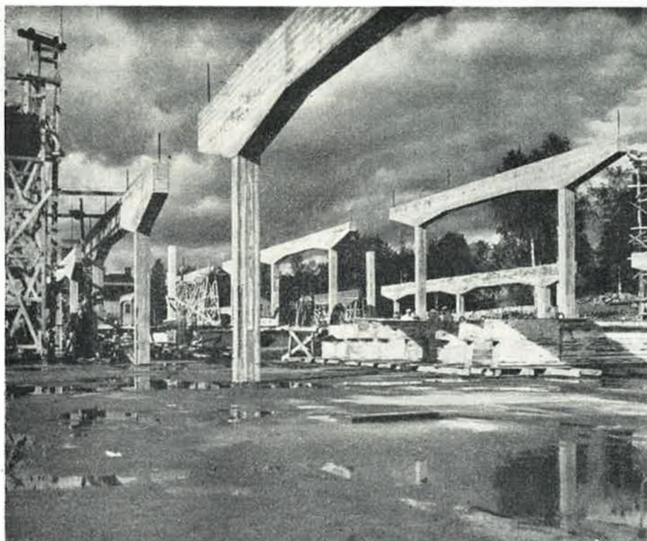
Vasemmalla: Syyskesällä otettu kuva varastotyömaalta: varaston komeita kehärakennelmia.
