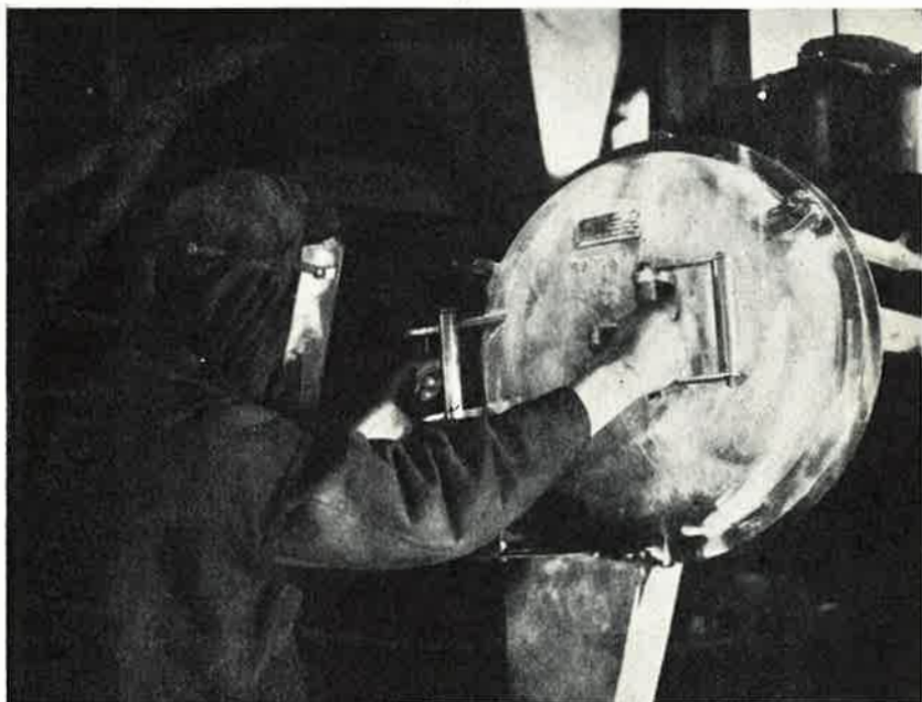
Henkilökohtaisten suojausten käyttöä ei tulisi koskaan laiminlyödä. Kuvassamme valimossa hiekkalingolla työskentelevä mies on suojannut silmänsä ja kasvonsa asianmukaisella tavalla perspex-suojalasin avulla.
