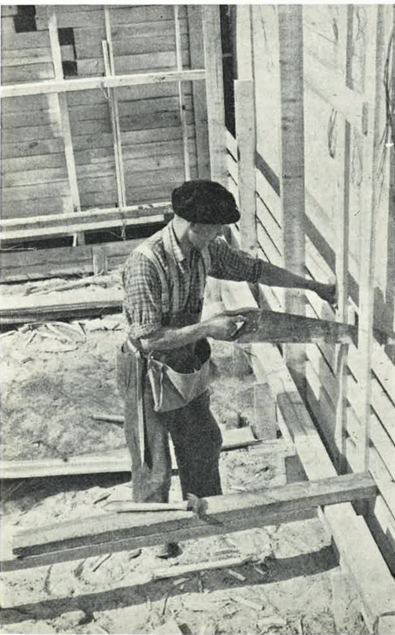
Olavi Jokelinin tontilla on pidetty kiirettä. Kuvassa sokkelin laudoitus meneillään. Syyskuun alussa suoritettiin jo betonivalu.
