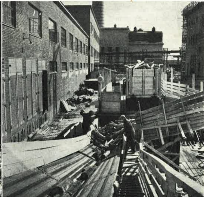
Vuorokauden keskeytyksen jälkeen alkoi hiomo saada riittävästi puuta tämän nopeasti rakennetun kuljetinlaitteen avulla.
