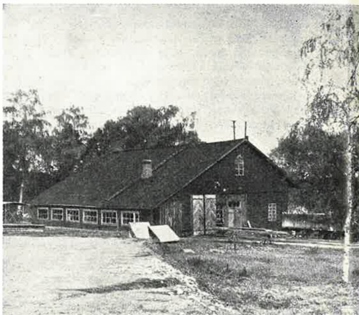
Vaunuverstaas on suorittanut tehtävänsä ja rakennusvanhus odottaa lähiaikoina tapahtuvaa purkamistuumiotaan.
