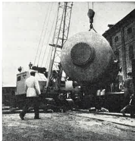
Pöntön paino oli Osgoodin kantokyvyn rajoilla, mutta viistoa alustukea apunaan käyttäen se selvisi hyvin urakastaan.
