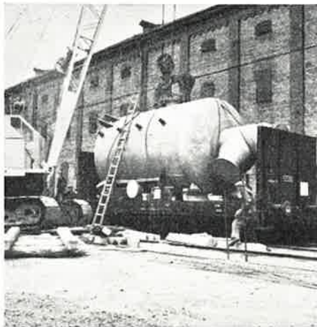
14,5 tonnia painavan haihduttamoon tulevan separaattoripöntön alta kulkevia nostovaijereita kiinnitetään Osgood-nosturin koukkuun.
