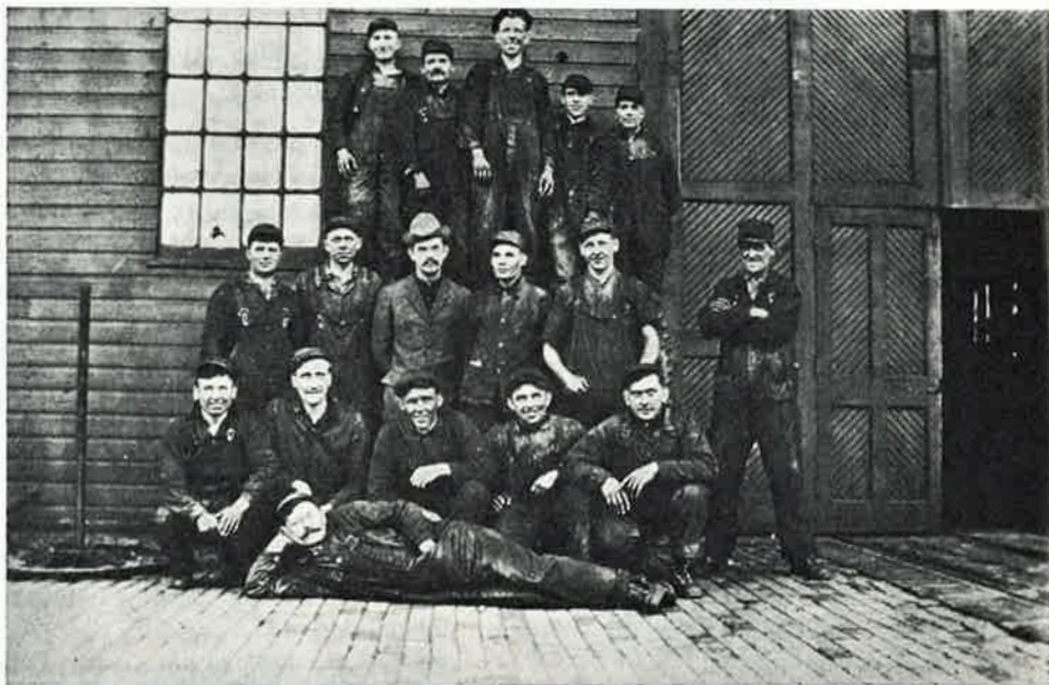
Amerikkalaisen teräslankatehtaan työmiehiä ensimmäisen maailmansodan aikoihin. Tämä työryhmä työskenteli säännöllisesti yövuorossa illasta klo 6:sta aamuun klo 7:ään
