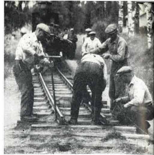
Paljon nopeammin käy rautatien purkaminen kuin rakentaminen
