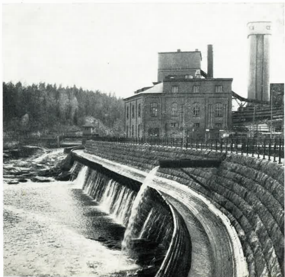
Voikankoskelle nykyisellään tunnusomaiset pitkittäiset patomuurit tullaan purkamaan
