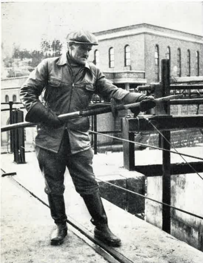
Martti Granath esittelemässä 'hyytöasettaan' Voikan puuhiomon padolla Jokaisen räjäytyksen jälkeen työnnetään holkkiin uusi pienoisanoksella varustettu puutikku
