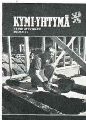
Omakotirakentaja Uljas Villa pikeämässä talonsa perustuksen betonilaattaa Kuusanniemen omakotialueella
