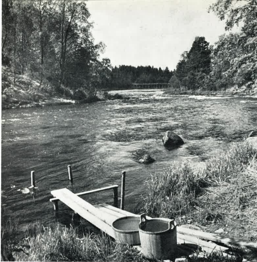
Menneen kesän kuva Karjalankoskesta Voimalaitos patoineen rakennetaan kosken keskipaikkeille
