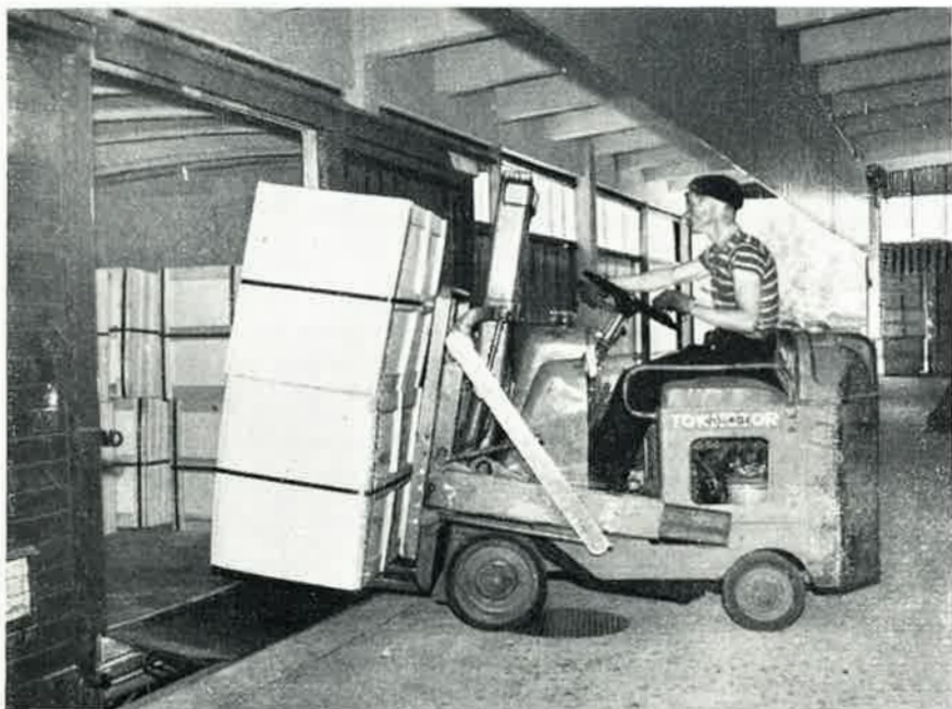
Lastaus rautatievaunuun tapahtuu täysin koneellisesti trukin avulla
