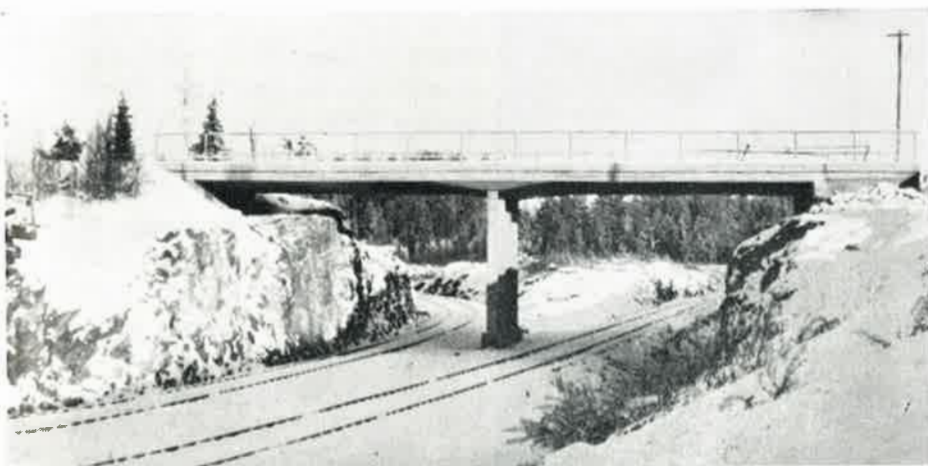
Rautatien ylikulkusilta Ruukintieellä Vasen raidepari vie Siilinjärvelle, oikea Juantehtaalalle
