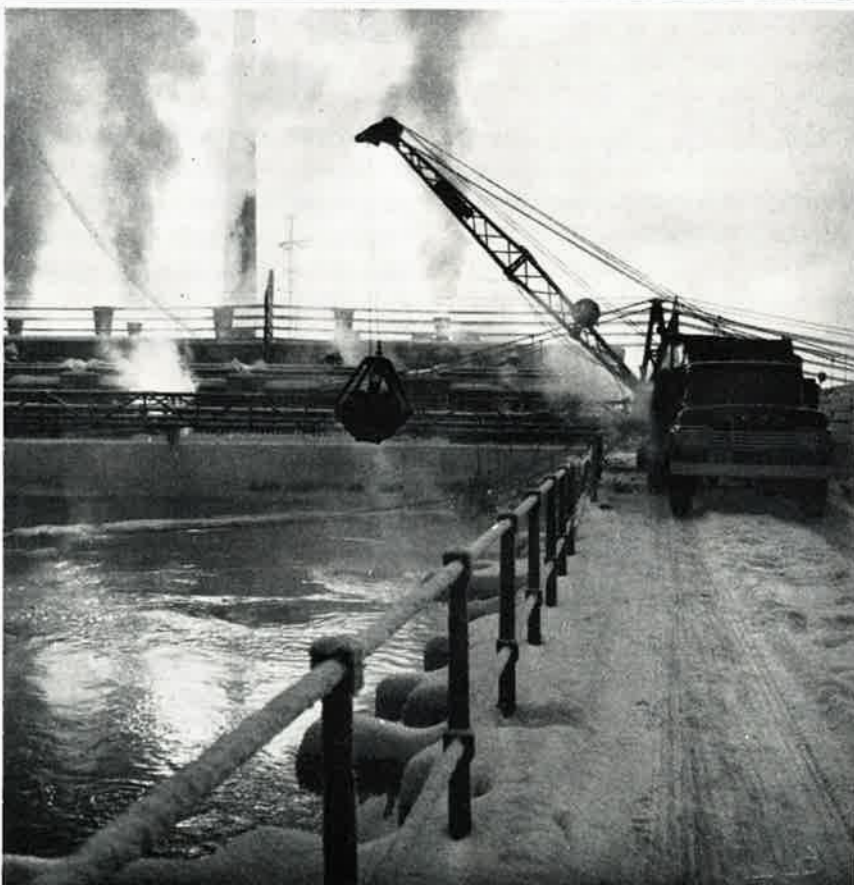
Huurteisen pakkaspäivän tunnelmia Voikan koskityömaalla
