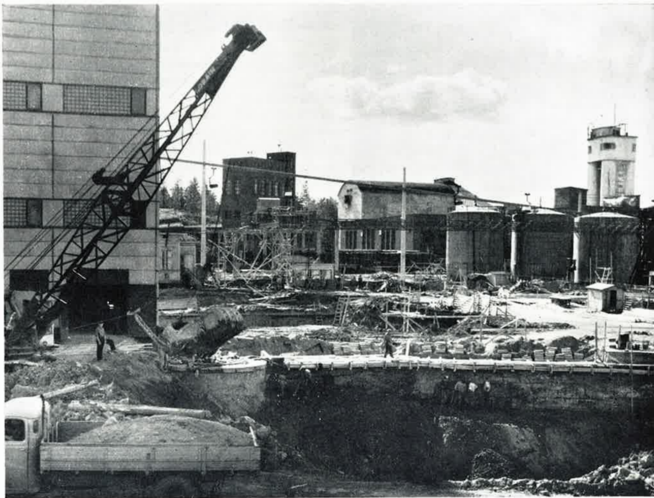
Historialliselle tehdaspihalle ilmestyi loppukesällä kolme suurta monttua samaan riviin rinnakkain
