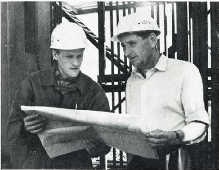
Vastaava työnjohtaja Tor Nordström (vas.) ja työnjohtaja Sven Henriksson korkeuksissa kattilarakenteiden ääressä
