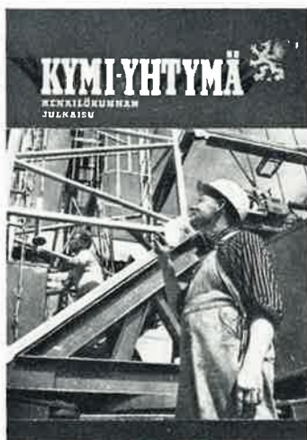
Kansikuvassa rakennusliike A. W. Liljeberg Oy:n miehet siirtämässä kaunislinjaisella ja tehokkaalla suurnosturillaan Voikan uuden kattilarakennuksen seinäelementtejä korkeuksiin.
