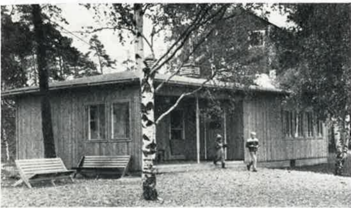
Kioski on liian vaatimaton nimitys näin komealle laitokselle
