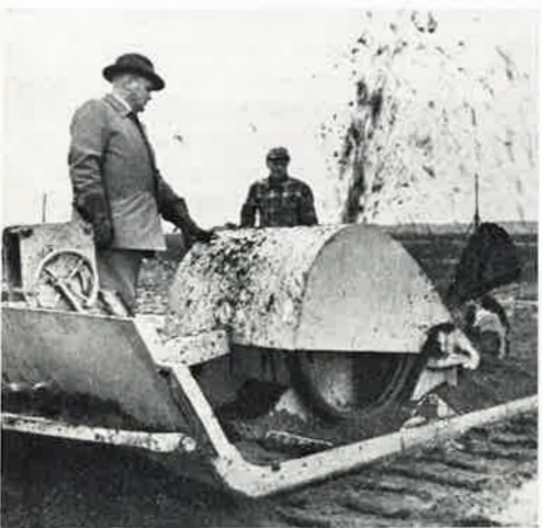
Ins. W. Ekelund on tyytyväinen monivuotisten kokeilujen tuloksena aikaansaatuun salaojituslaitteeseen, jolla syntyy hyvää salaojaa kolme metriä minuutissa
