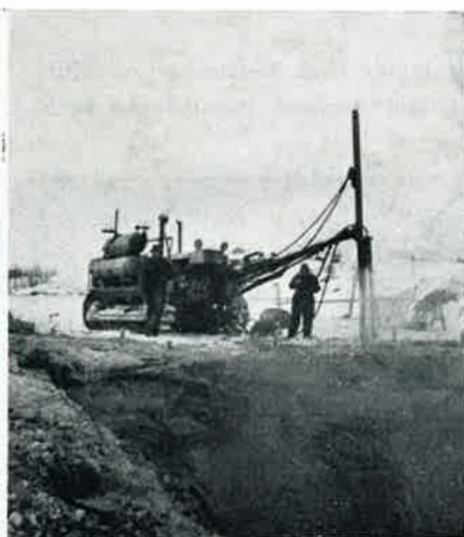
Työpatoa tehdään Pekkolanvirtaan ja kallioraukset suoritetaan tehokkaalla vaunuporakoneella
