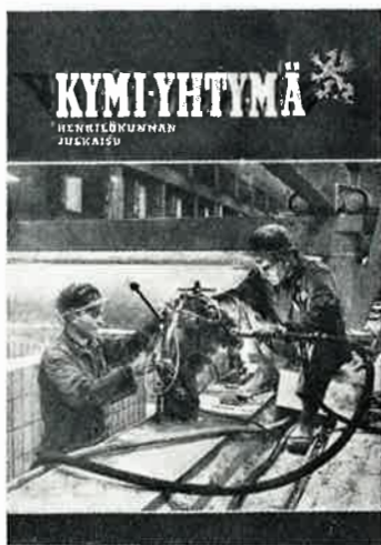
Valmetilaiset asentajat Jukka Siren (vas.) ja Antti Töyli Voikan uuden paperikoneen asennustöissä. Ks. kirjoitusta 'Paperikonetta asennetaan' ss. 4—7.
