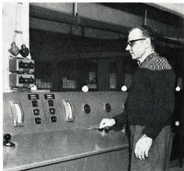
Vesilaitoksen hoitaja Arvo Hölsä hoitopöydän ääressä hiekkasuodattimia puhdistamassa
