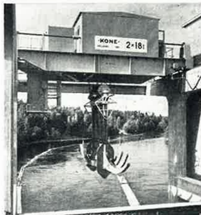
Nippunosturi siirtää puuniput voimalaitoksen padon yli alavirran puolelle
