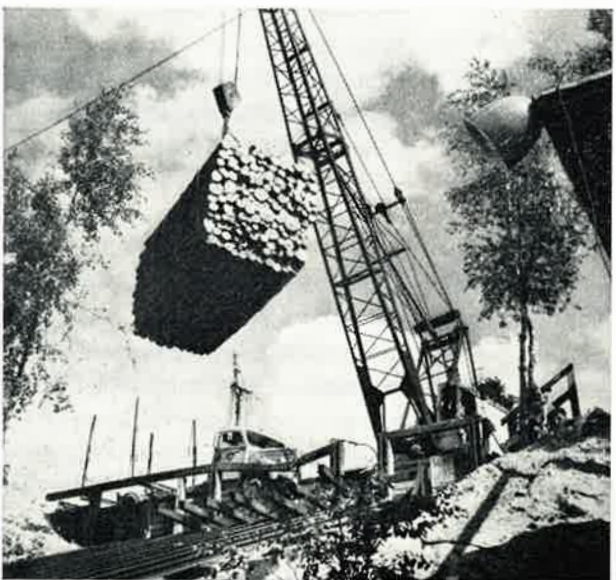
Juna- ja auto-kuljetuksina tulleet puut siirtää nosturi laskutelineelle, josta ne liukuvat rantavieruun tehtyä mäkeä myöten vesivarastoon
