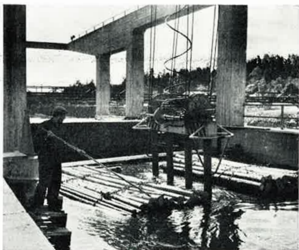
Nippukanavassa kaksi nippua kerrallaan ohjataan nosturin vedessä olevien nostokoukkujen päälle
