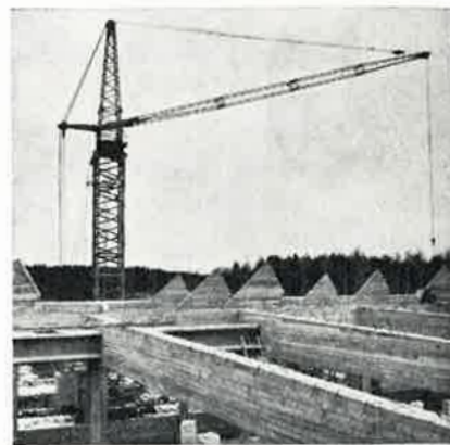
Korjauspajan kattopalkistoa valmiina vastaanottamaan kattolevyjä
