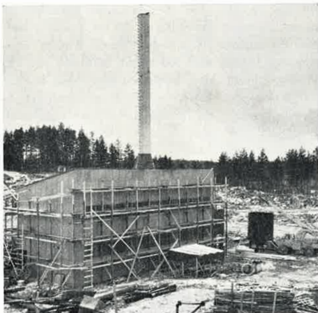
Teräslevystä tehty apukattilan savupiippu on Kuusanniemen ensimmäinen tehdassymboli
