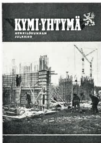
Kuusanniemen tehtaan kuitulinjaa rakennetaan
