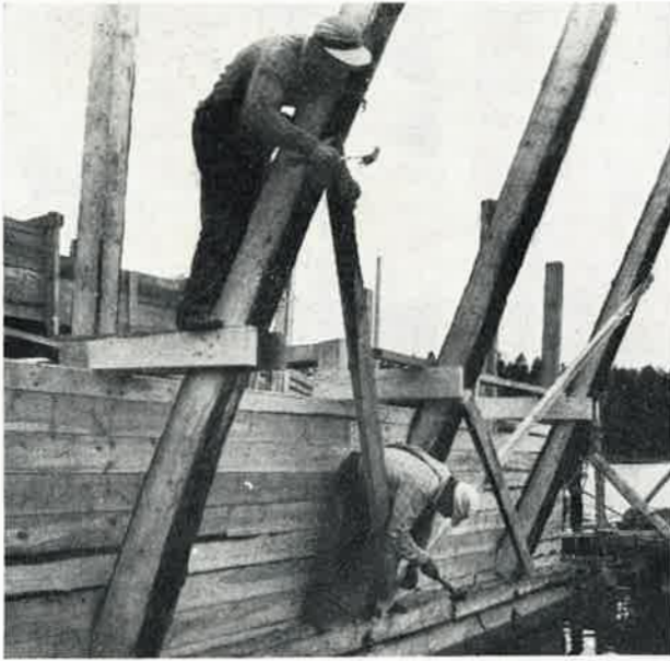
Rapakosken sillan maatukien arkkuja rakennetaan Kymijoen päällä
