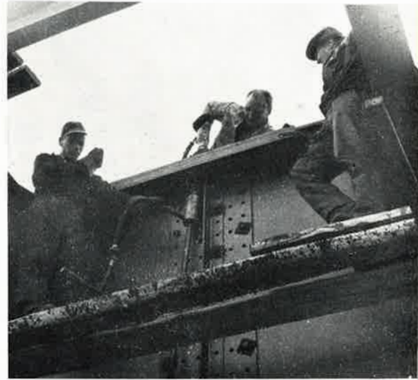
Hitsaamalla tehtyjä sillanosia niitataan yhteen siltatyömaalla
