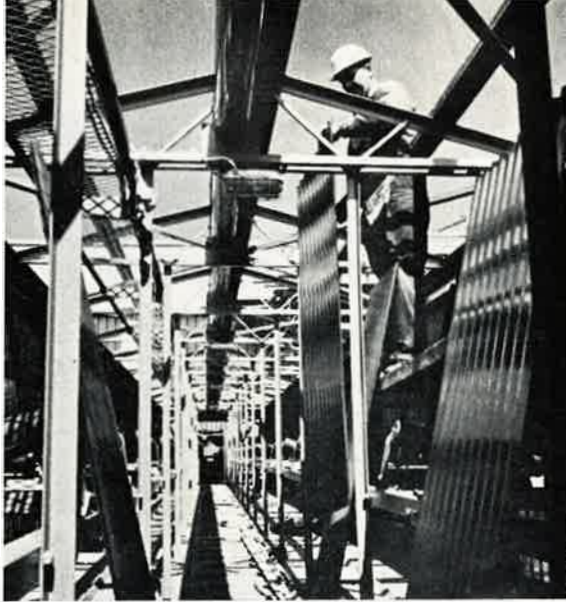
Lastukuljettimen kattolevyjä kiinnitetään
