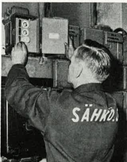
Kuva 4. Sähkömies on saapunut paikalle kiristämään öljypumpun ohjausnappia ja irroittamaan ensimmäiseksi sulakkeet
