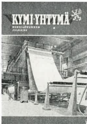
Hohtavan valkoinen koivuselluloosa laskeutuu näin mahtavana 'lakanana' kuivauskoneesta arkileikkuriin
