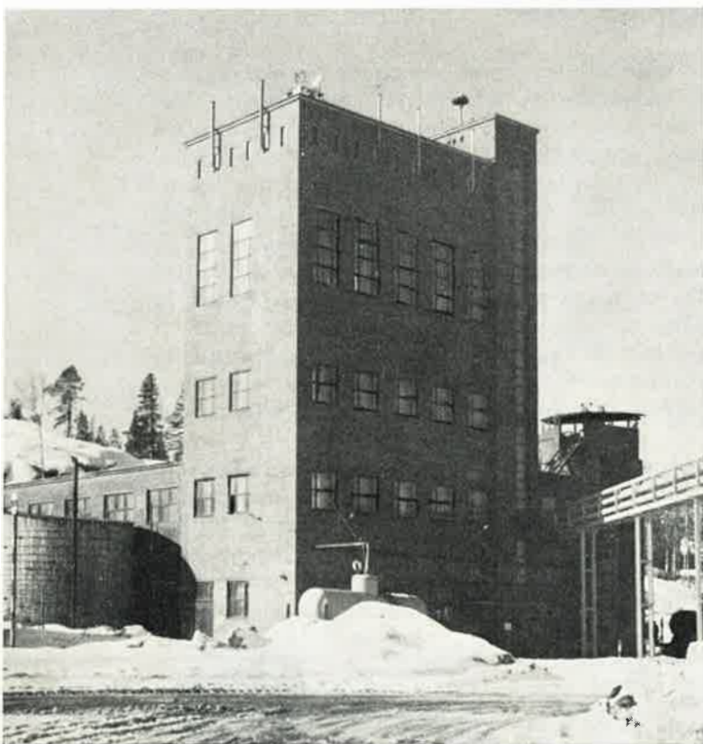
Spriitehdas on uusittu perusteellisesti, mutta rakennuksen ulkonäkö on pysynyt entisellään
