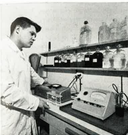
Prosessin edistyminen alusta valmiiseen tuotteeseen saakka vaatii jatkuvaa käytöntarkkailua. Viljo Pyykkönen metanolin määrittystä tekemässä.
