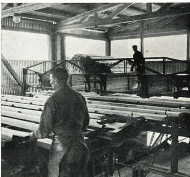
'Paketin' kerrokset muodostuvat koneellisesti rimoituskoneen jakopöydällä
