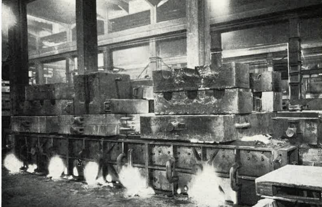
Putkivalukoneen neljän tonnin painoinen koneenrunko on juuri valettu ja kaasuuntuneet keernan sideaineet palavat kaasujen poistoaukkojen kohdalla
