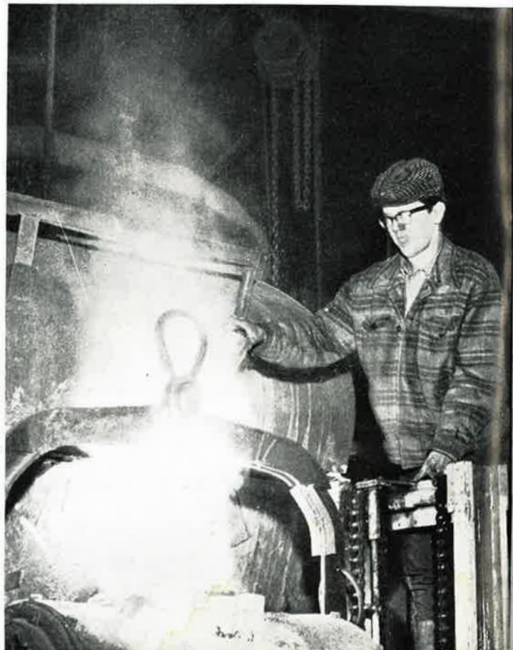
Keernantekijä Heikki Lindholm valmistamassa ulkomaille menevän syklooniuunin tuhkakaukalon keernaa
