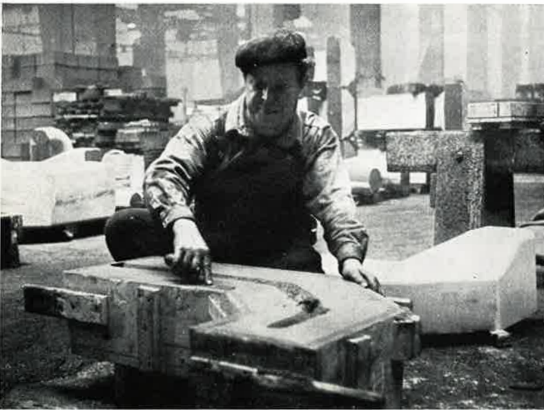
Keernantekijä Heikki Lindholm valmistamassa ulkomaille menevän syklooniuunin tuhkakaukalon keernaa
