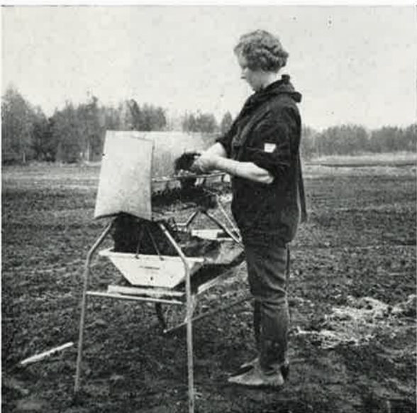
Lajittelun läpäisseiden taimien istuttaminen koulutuspenkkeihin tapahtuu tällaista kevytrakenteista pyörillä varustettua laitetta apuna käyttäen
