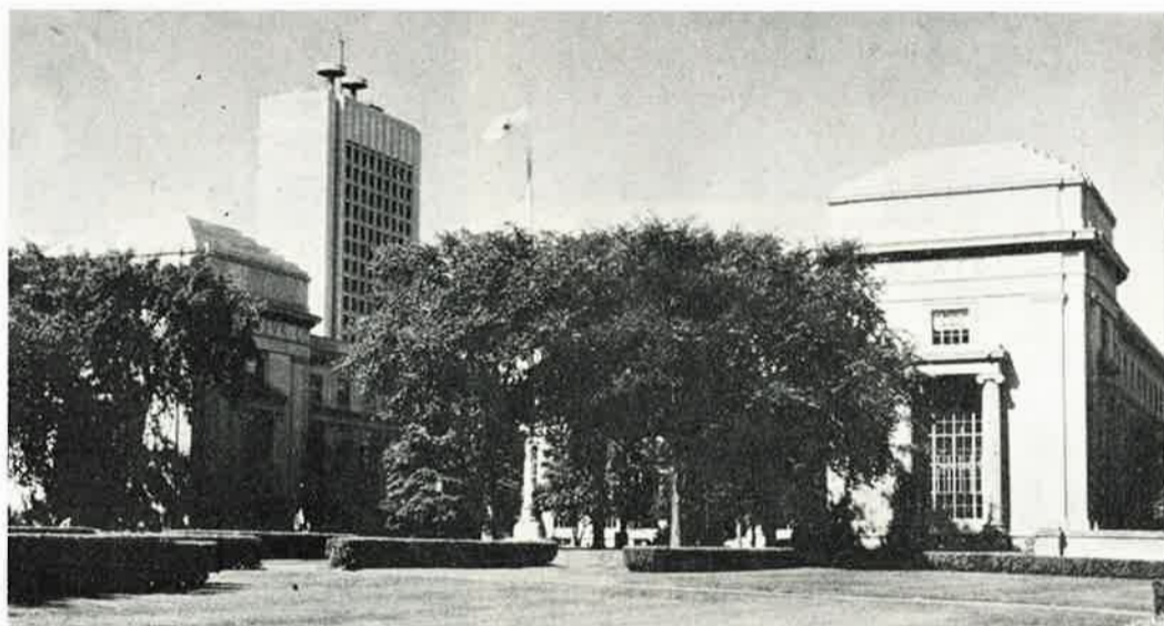
Osa M.I.T:n keskusrakennuksia. Korkeassa rakennuksessa on geologinen tutkimuslaitos.
