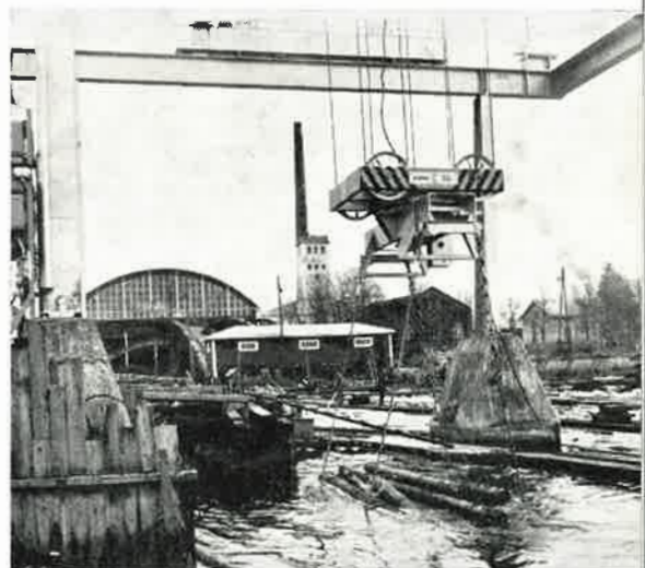
Vesivarastoon siirrettävät niput lasketaan purkauspai- kan ääreen kaivettuun uittokanavaan
