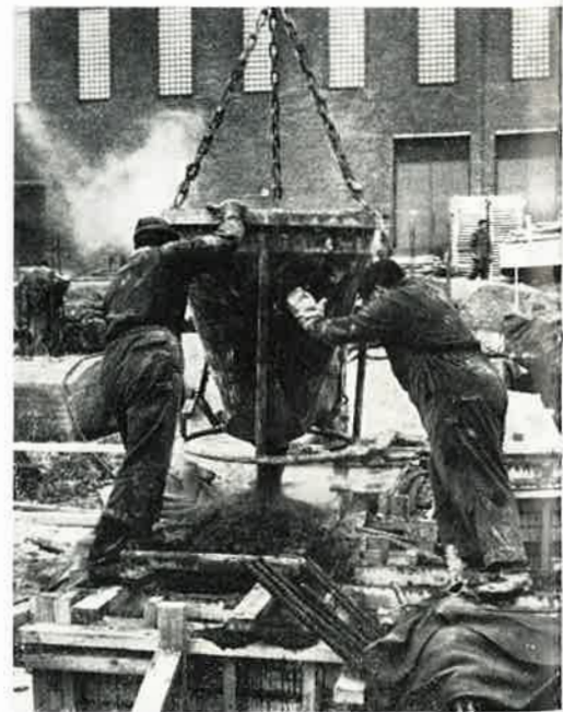
Kuusankoskelainen Betonipojat toimittaa rakennukselle betonin
