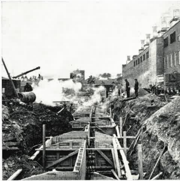
Konehallin perustuksia rakennetaan lyöntipaalujen varaan
